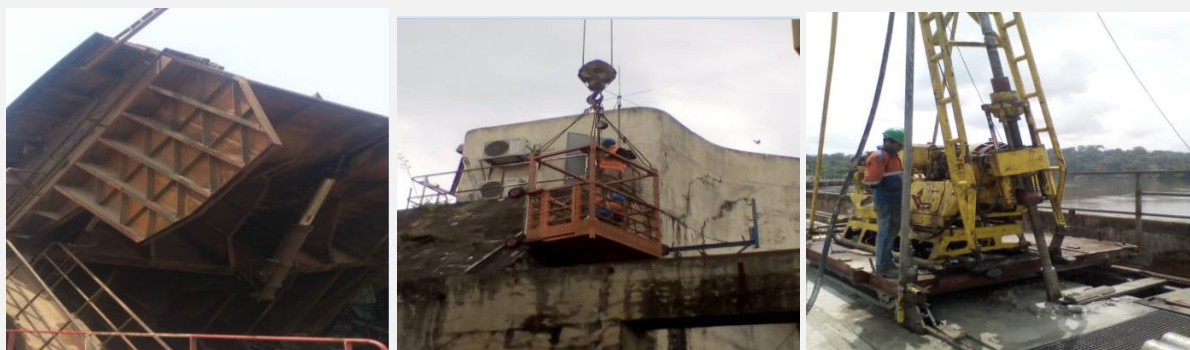
Travaux de sécurisation du barrage hydroélectrique de Songloulou
