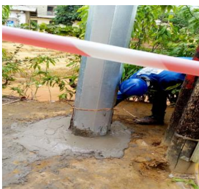
Poteaux métalliques en MT
