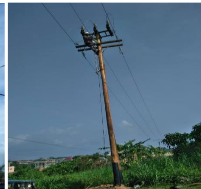
Extension réseaux Moyenne Tension
