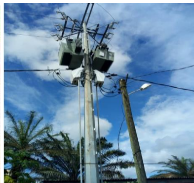
Décharge des transformateurs
